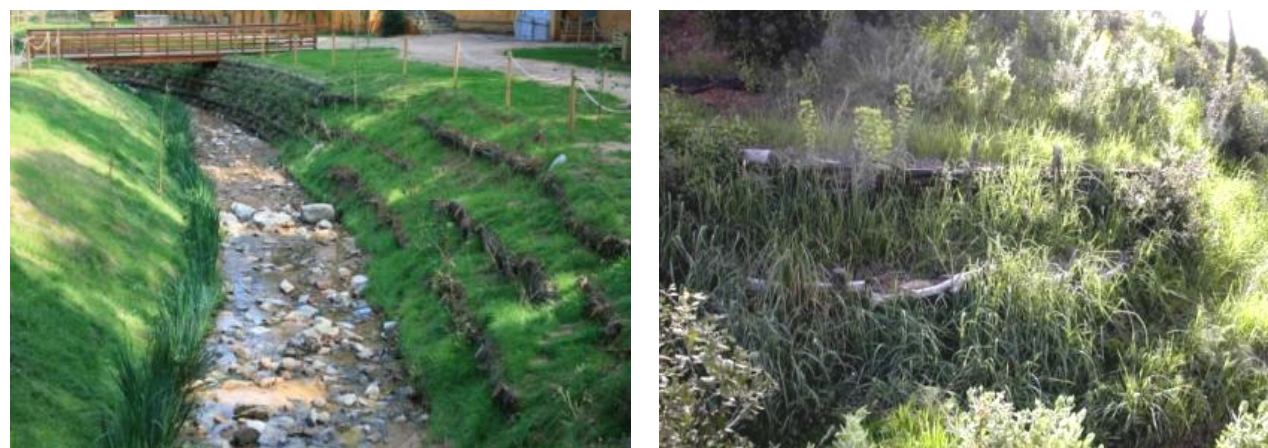
Figura 11 Exemples de feixines
