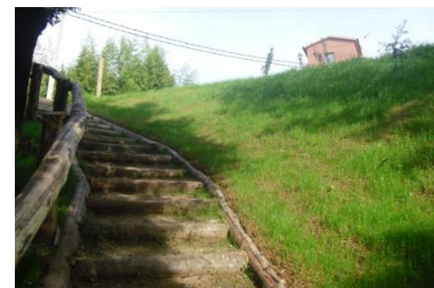
Figura 9 Exemple d'escales de fusta de castanyer executades per Naturalea
