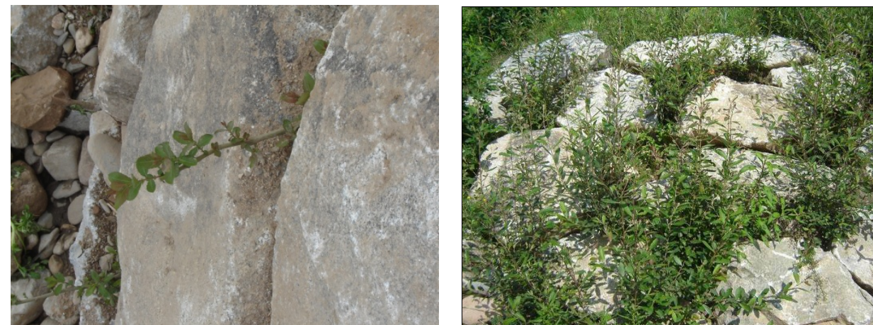
Imatges d'escullera revegetada
