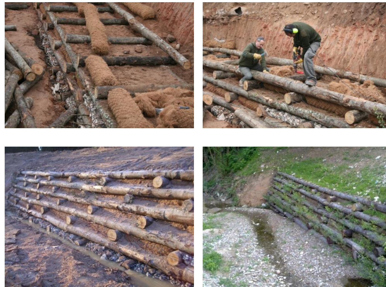
Figura 6. Procés constructiu d'un entramat Krainer
