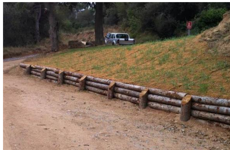
Figura 8 Exemples de palissades executades per Naturalea
