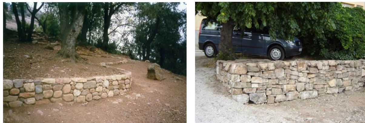
Imatges de marges de pedra vista collada executats per Naturalea
